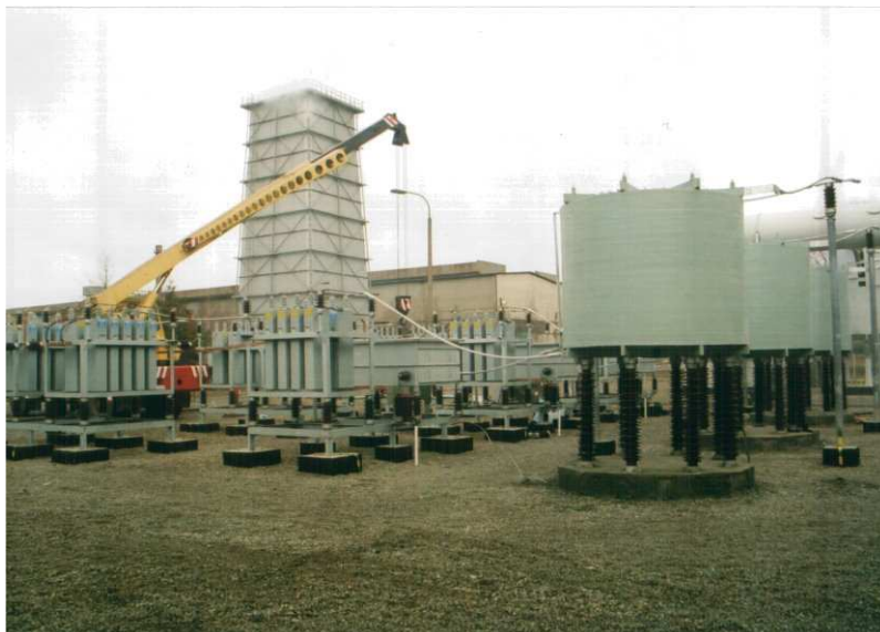
Filtr typu „C” 2-giej harmonicznej z rezystorami tłumiącymi. Zdjęcie w trakcie prac
