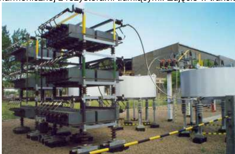
Filtr typu „C” 2-giej harmonicznej z rezystorami tłumiącymi. Zdjęcie w trakcie prac
