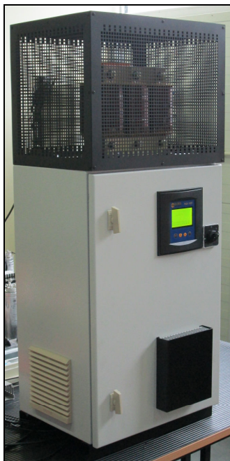
Rys. 2. Kompensator mocy biernej pojemnościowej typu TN-D
