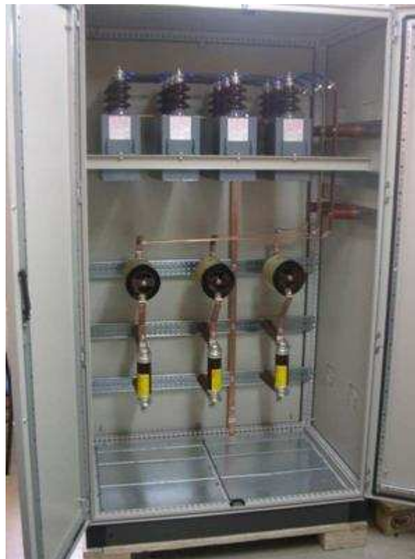
Rys. 1.2 Cewki ograniczające prąd załączania baterii (członów baterii automatycznie regulowanej)
