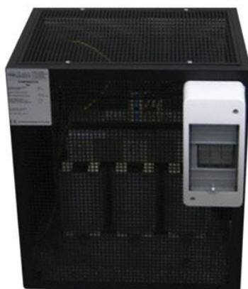
Przykładowe wykonanie nieregulowanej baterii KD w osłonie perforowanej
