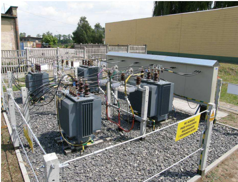
Filtr transformatorowy 20kV z łącznikami stykowymi
