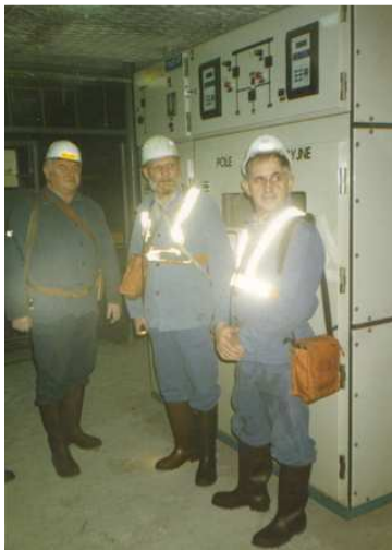
Fot. 2. Bateria kondensatorów BSCR-3 z trójfazowymi kondensatorami 6,3kV. Realizacja ELMA energia w ZG Lubin KGHM „Polska Miedź”
